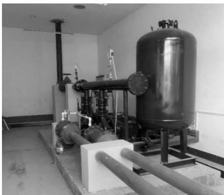
图 2 变频恒压供水系统
